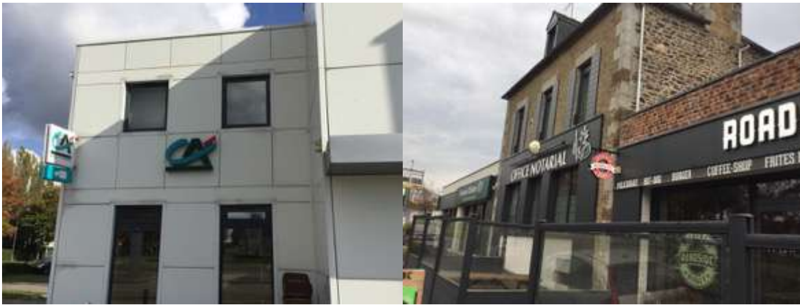
Enseignes perpendiculaires bien intégrées au bâtiment et alignées à l'enseigne parallèle au mur, Lécousse, octobre 2019.
