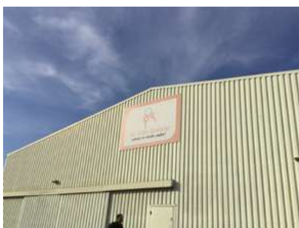
Enseignes parallèles dépassant des limites du mur ou de l'égout du toit, Lécousse, octobre 2019.
