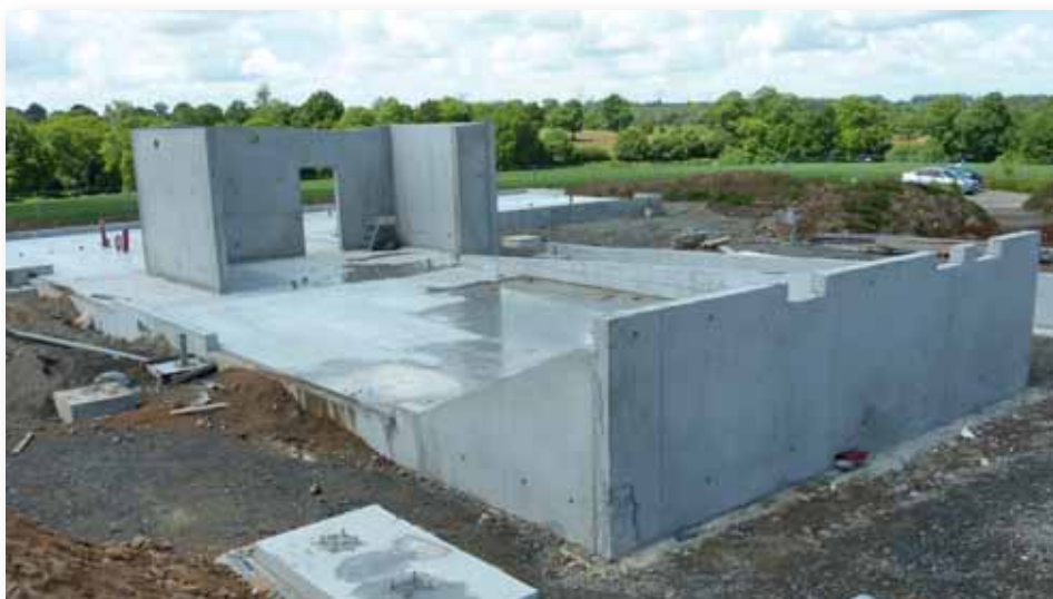
▲ La construction des fondations en béton est terminée
