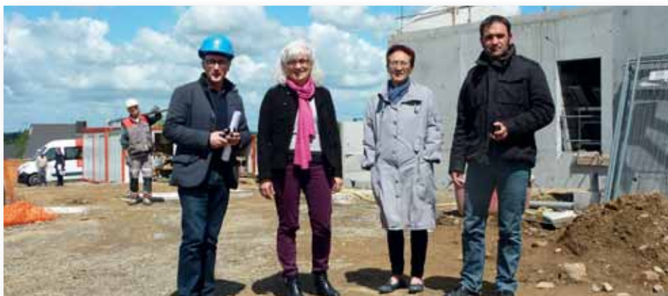
▲ Visite de chantier hebdomadaire
