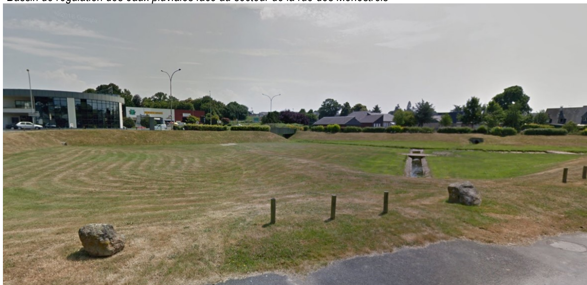
Bassin de régulation des eaux pluviales face au secteur de la rue des Ménéstrels
