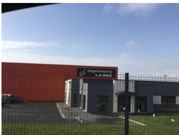
Enseigne parallèle réalisée avec un panneau de fond, Lécousse, octobre 2019.
