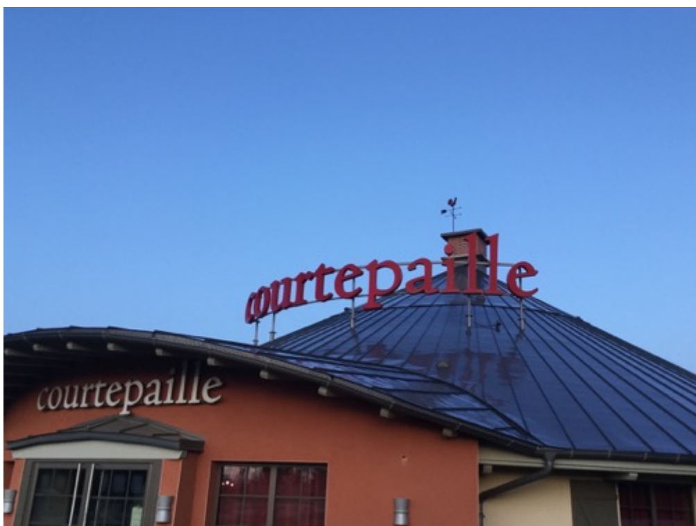
Enseigne sur toiture ou terrasse en tenant lieu en lettres découpées d'environ 12m 2 , Lécousse, octobre 2019.
