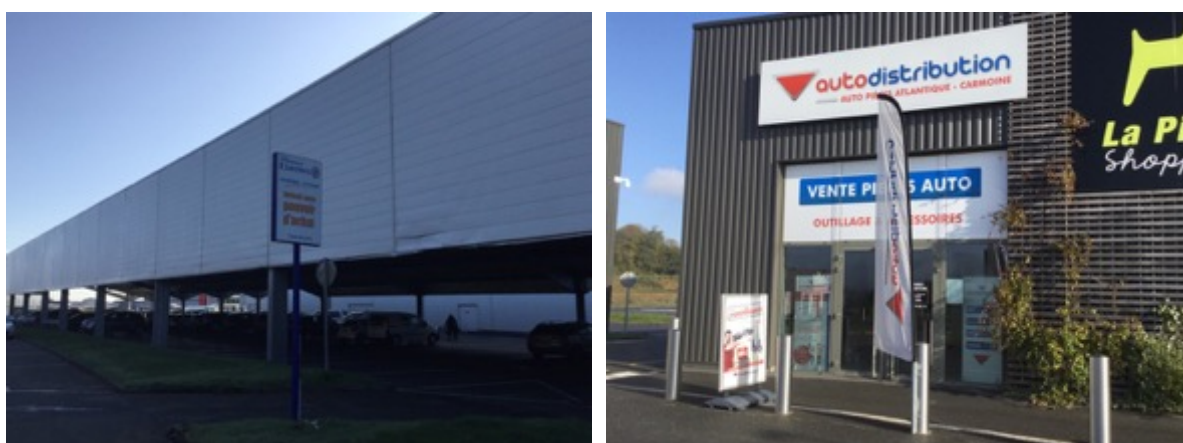
Enseignes scellées au sol ou installées directement sur le sol de type « mât », « chevalet » et « drapeau », Lécousse, octobre 2019.
